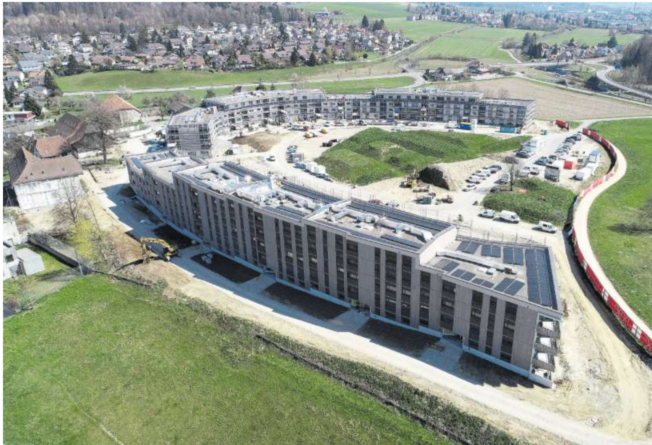
Die Arbeiten auf dem weitläufigen Areal befinden sich auf der Schlussgeraden.
